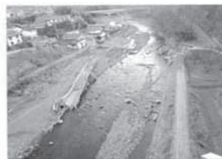
【現在の鹿曲川】 破損した地久保橋。 台風 19 号のため幅広くなった。 草木がきれいに流され、石ころがたくさん流れてきて川の姿が変わった。日照の良い日は水が透明できれいな川にかわった。
